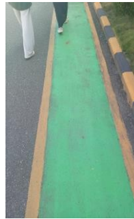
Gambar 4. Jalan Jalur Evakuasi Ditandai Dengan Cat Hijau
