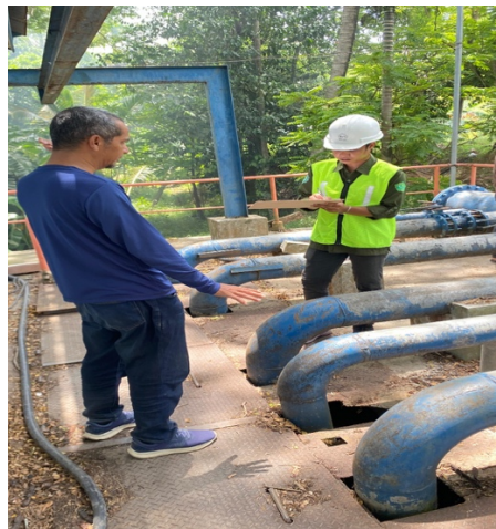
Gambar 0.2 pengecekan pipa air
