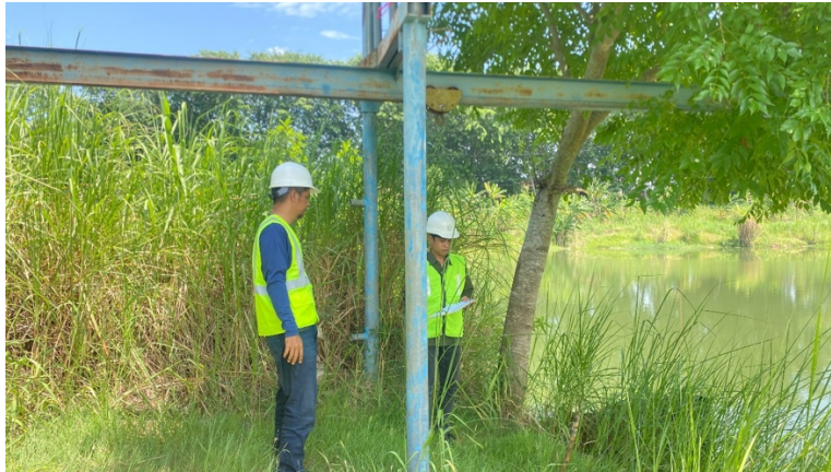
Gambar 0.3 pengecekan pompa air di krueng aceh
